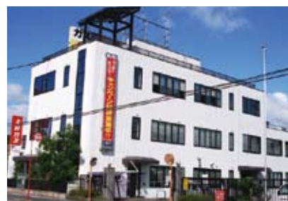
▲上野ガス(株)、上野都市ガス(株)本社事務所
