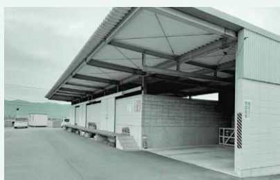
高圧ガス貯蔵庫
